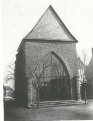
Das alte Chörchen wird gründlich renoviert, der Triumphbogen geöffnet und mit einer Glaswand versehen. Wiederherstellung des Grabgewölbes und Einbau eines neuen Fußbodens. Gesamtkosten: 46 173,- DM.
